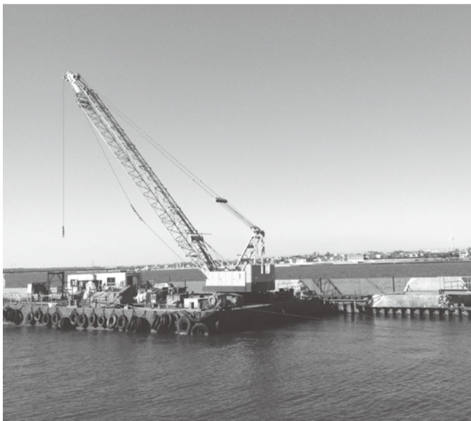
計画的に進める防波堤の補修工事
