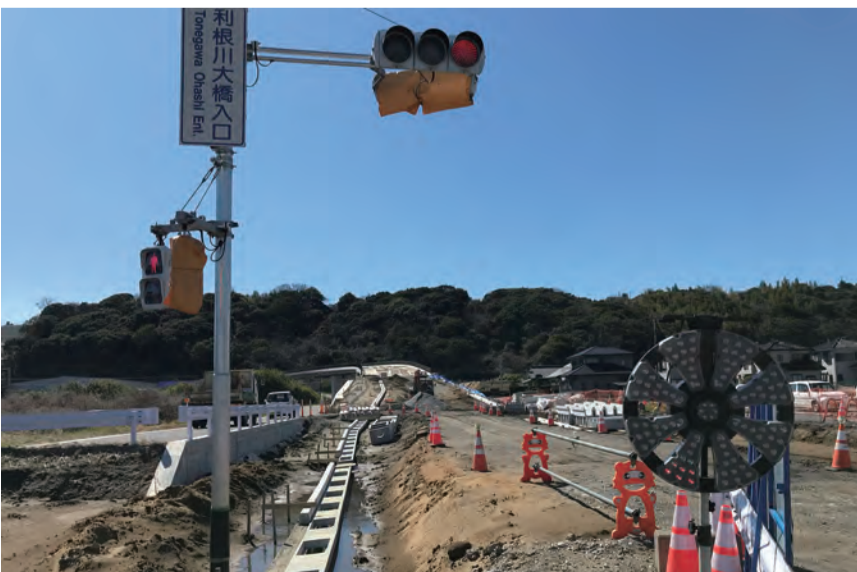
急ピッチに工事が進む北ルート (R6.3月9日現在)
