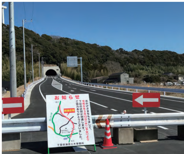
工事が完了した清滝バイパス (R6.3.9撮影)
