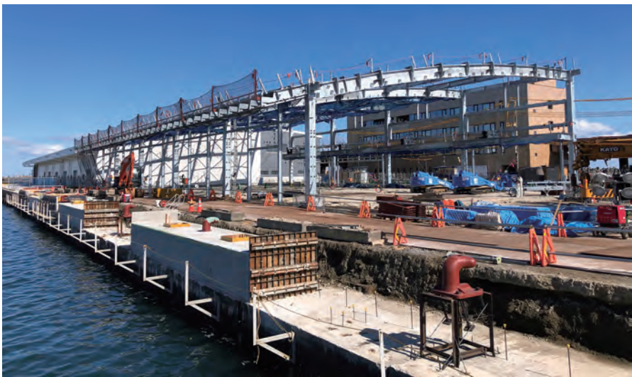
建設が進む高度衛生管理型 第3卸売市場
